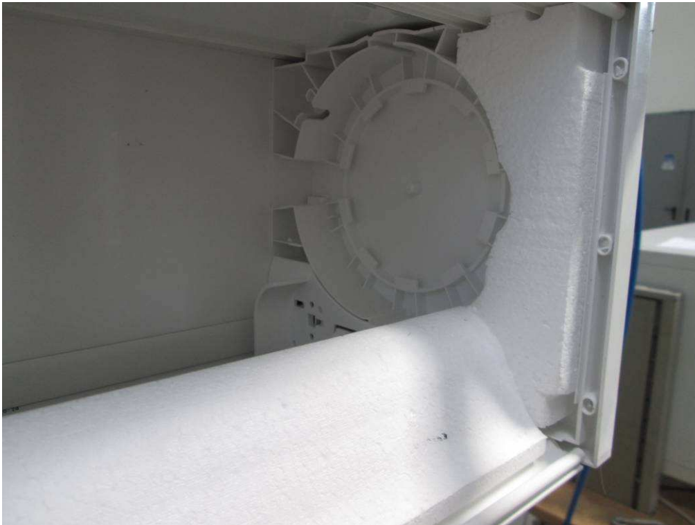
Bild 7 Innenaufbau Rollladenkasten mit Kopfstückdämmung und Revisionsdeckeldämmung
