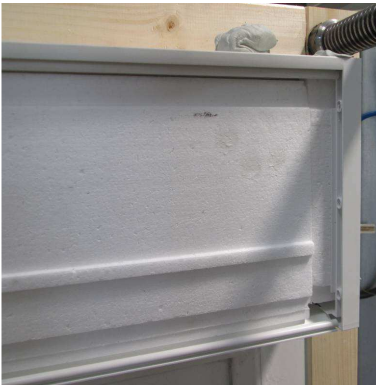
Bild 5 Rollladenkasten Frontplattendämmung
