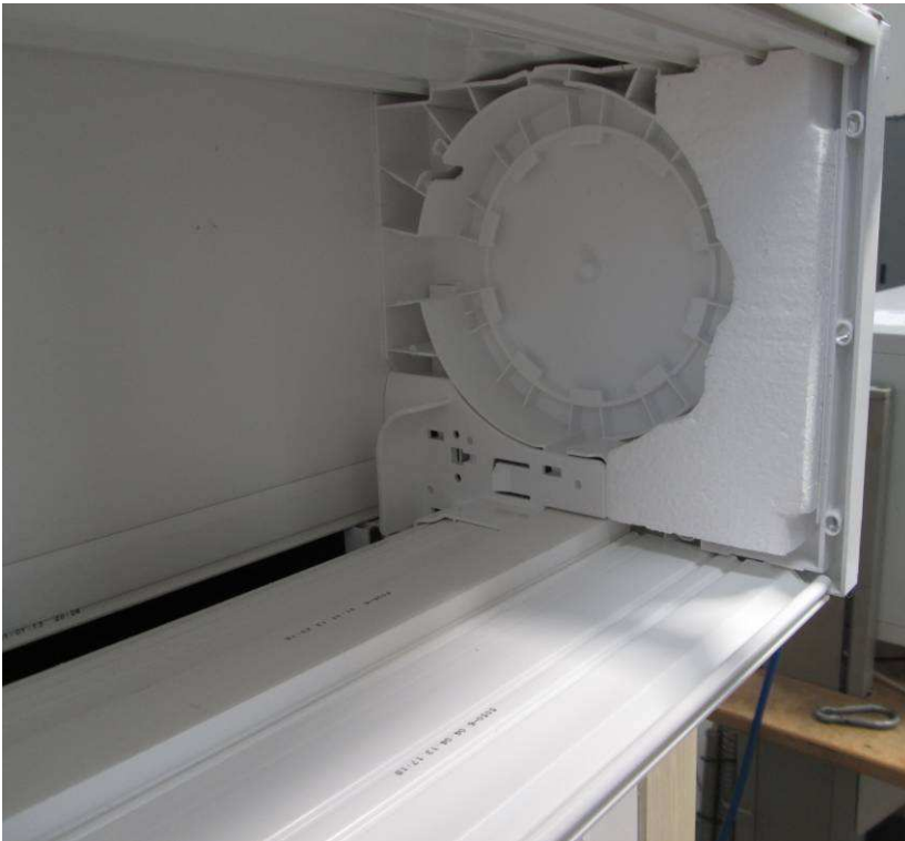
Bild 9 Innenaufbau Rollladenkasten mit Revisionsdeckel
